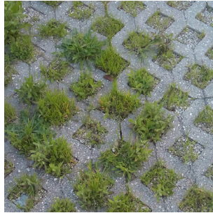
Fig. 64 Exemplos de pavimentos permeáveis
